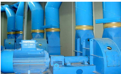
Fig. 3. Turboreactores asociados a la tecnología de recogida neumática
