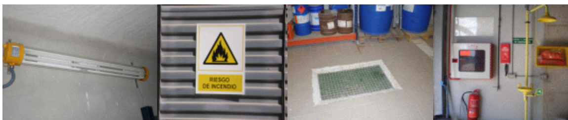
Figura 8. Almacenes legalizados para el almacenamiento de productos químicos.
