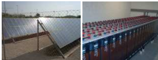
Figura 10. Placas solares y sala de baterías de la Planta Fotovoltaica asilada
