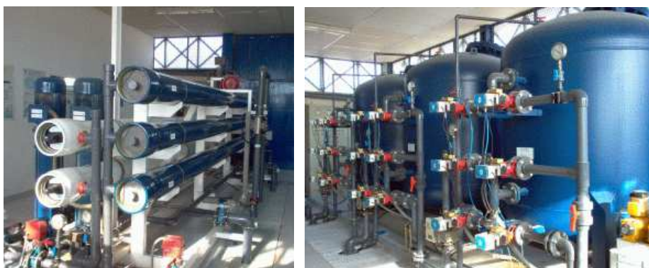
Figura 14. Planta Desaladora por ósmosis inversa
