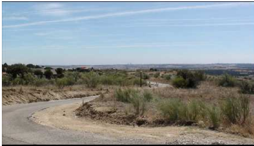
Foto 8_vista del trazado de la vía
