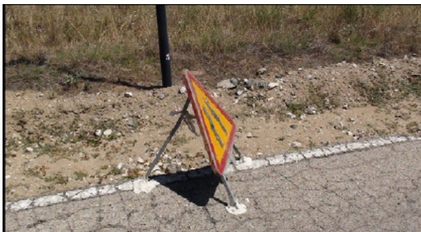
Foto 13_ Detalle de sujeción de la señalización de la vía
