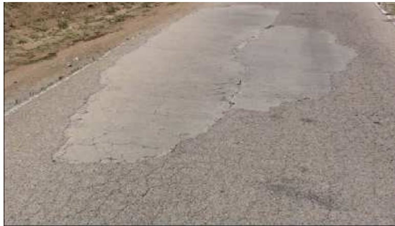
Foto 14_Parcheado de la carretera de acceso a la urbanización Jarabeltrán
