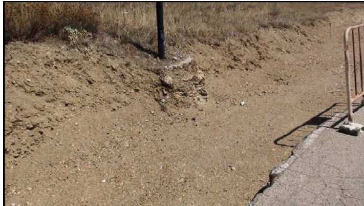
Foto 5_Detalle de cimentación de luminaria
