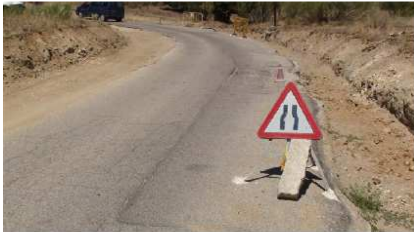
Foto 12_ Detalle de señalización
