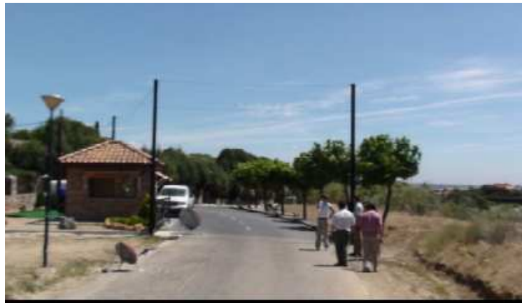
Foto 16_Acceso sur a la urbanización Jarabeltrán
