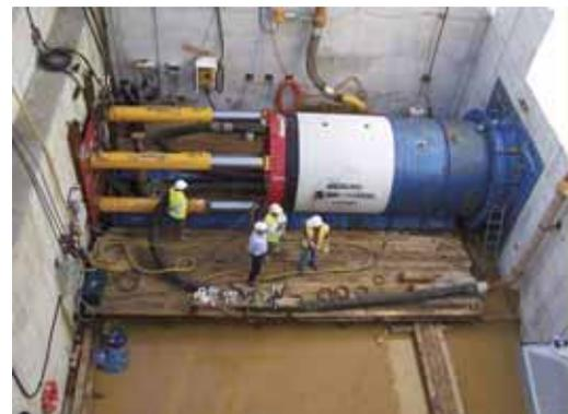
Foto 6: Comienzo de la excavación del túnel hincado
