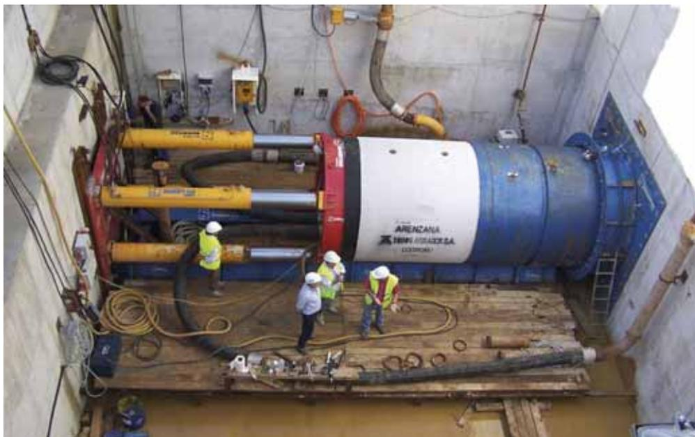
Imagen del comienzo de la excavación del túnel hincado mediante tuneladora
