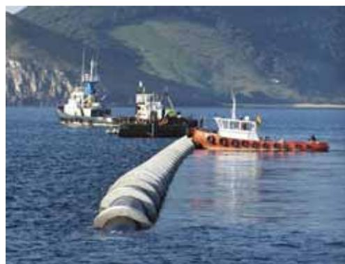
Foto 11: Alineación de la tubería en la maniobra de fondeo
