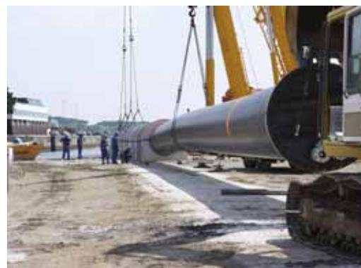
Foto 18: Colocación de lastres, tapas y bridas en la tubería de polietileno
