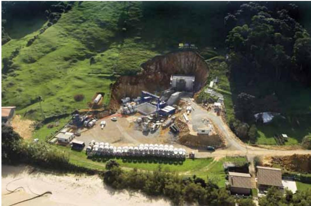
Imagen que muestra el estado de la obra en sus primeras fases y el considerable desmote que hubo que hacer en la ladera para la construcción de la cámara de carga
