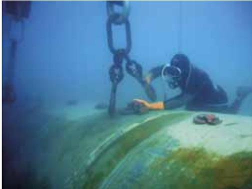
Foto 7: Rescate de la tuneladora mediante buzos
