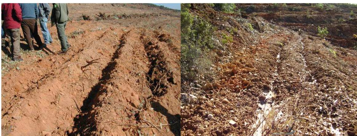
Figuras 5 a) y b). La realización de surcos o zanjas de contorno, además de reducir significativamente la erosión hídrica, aumenta el tiempo de permanencia del agua en la ladera, favoreciendo la infiltración natural, la recarga de los acuíferos y el mejor desarrollo de la posterior plantación.
