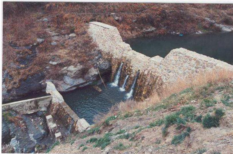
Figura 7. Dique en un torrente de Sierra Nevada (Granada). Laminan el caudal punta y aumentan la infiltración natural
