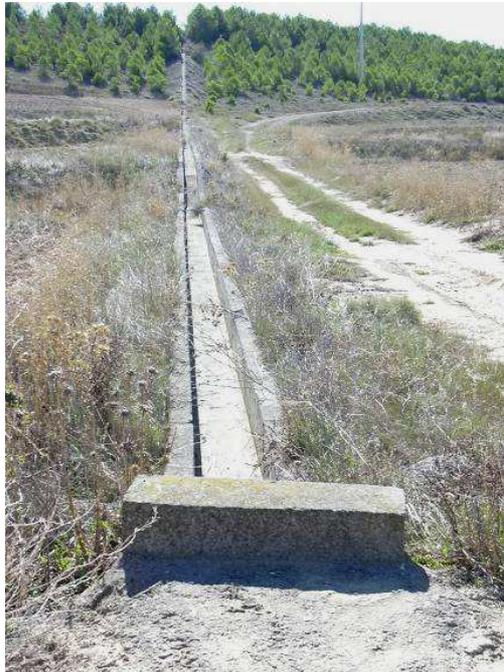
Figura 9. Zanja de drenaje en una ladera. La recolección del agua de lluvia, reduce la erosión y permite un mayor aprovechamiento de la escorrentía. Navarra.
