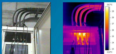
Figura 4. Representación termográfica de cuadro eléctrico industrial
