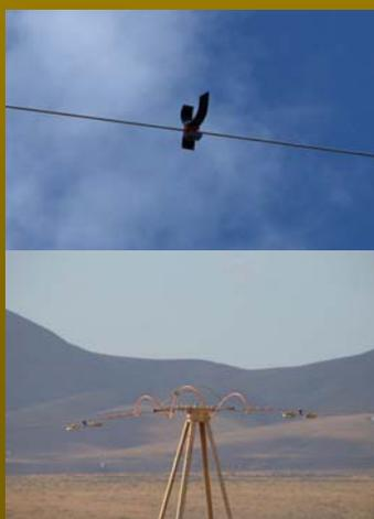
Las medidas implantadas consistieron básicamente en la colocación de aislamientos en apoyos y conductores, para evitar electrocuciones, señalización de conductores con dos tipos de balizas (espirales y tiras de neopreno, para evitar las colisiones y la sustitución de antivibradores por otros helicoidales, para evitar los enganches.
