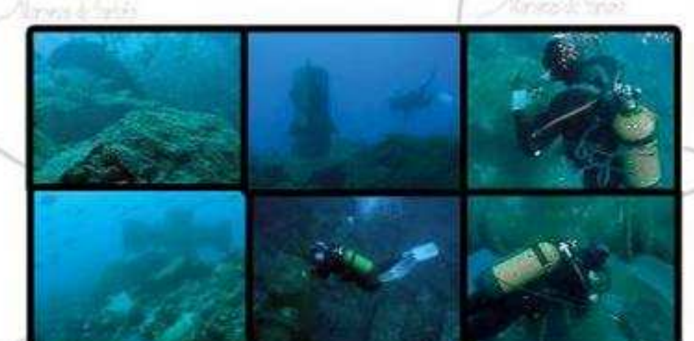
EL EQUIPO DE BUCEADORES AJUSTA LOS DIFUSORES COLOCADOS EN EL EMISARIO YA FONDEADO
