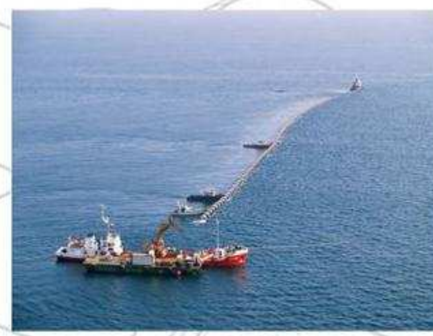
PROCESO DEL FONDEO DE LA TUBERÍA
