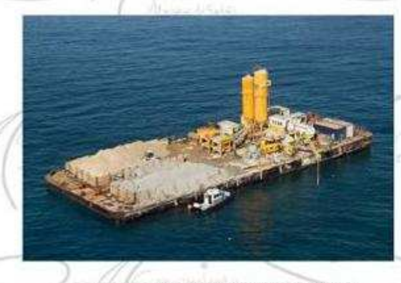
PONTONA CON PLANTA DE HORMIGONADO
