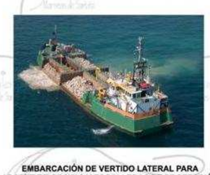
EMBARCACIÓN DE VERTIDO LATERAL PARA APOORTE DE GRAVAS Y ESCOLLERAS DE PROTECCIÓN DEL EMISARIO SUBMARINO
