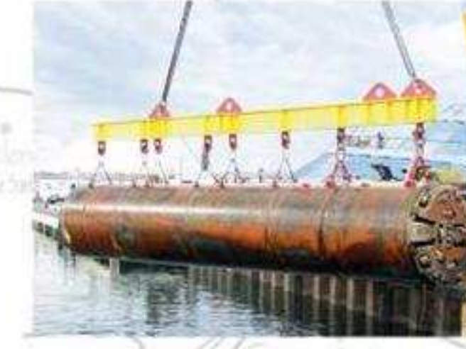
RESCATE DE LA TUNELADORA POR MEDIO DE UNA POTENTE GRÚA
