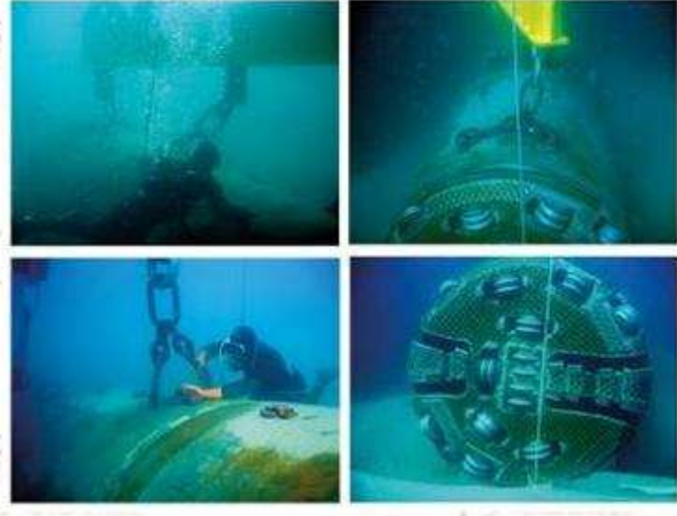
BUCEADORES PREPARAN LA MANIOBRA DE RESCATE DE LA TUNELADORA
