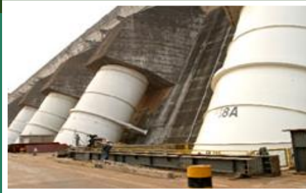
UNIDADES GENERADORAS ADICIONALES
