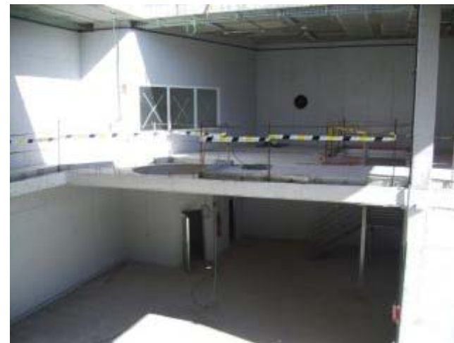
Acceso Central RNRU y sala de control
