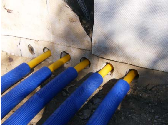
Figura 8.11: salida de tuberías de la Central
