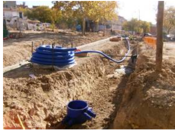
Figura 8.12: red de tubería y arqueta
