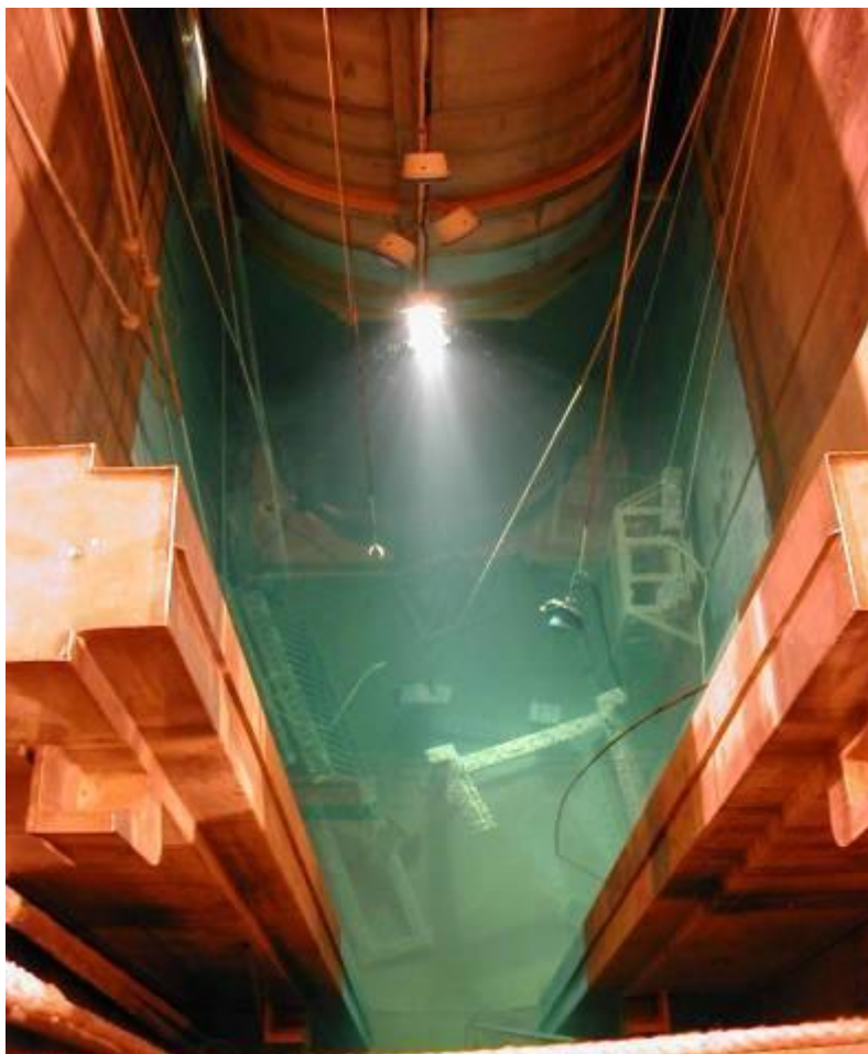
Estado Inicial Piscina del Reactor
