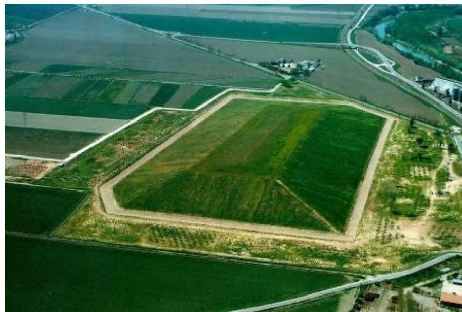
Estado final del emplazamiento después de las labores de desmantelamiento realizadas por ENRESA
