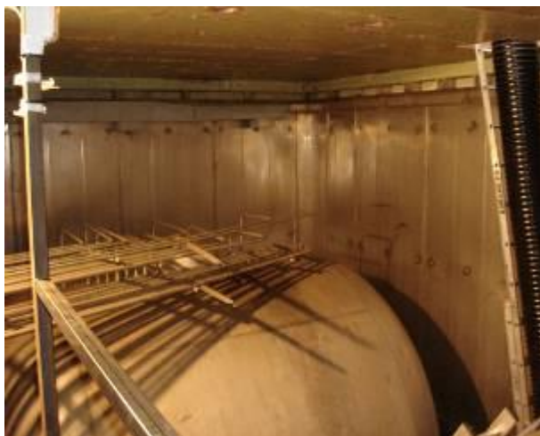
Tanque a desmantelar en celda subterránea
