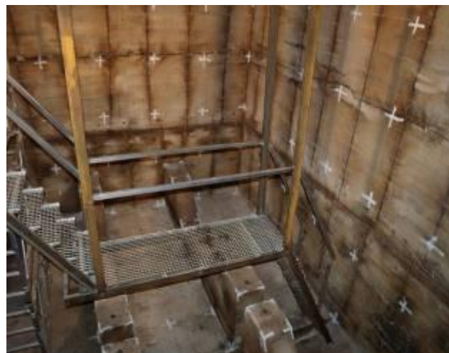
Estado final Unidad de intervención
