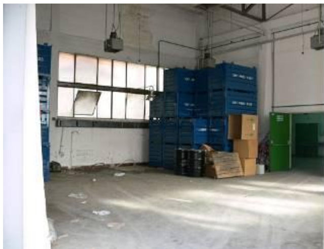
Estado inicial Edificio 11 Anexo
