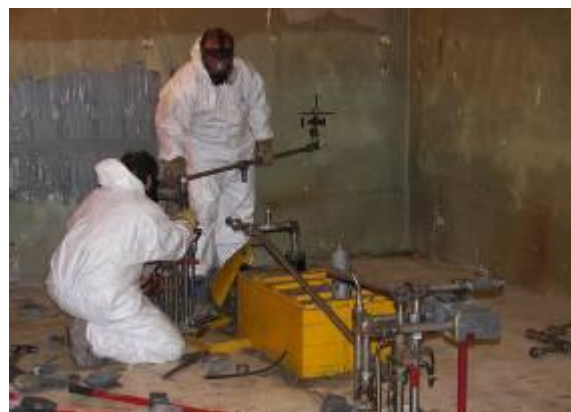
Desmontaje en techo de celdas
