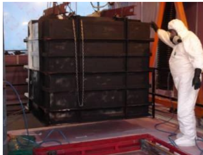
Extracción del tanque de alta A1
