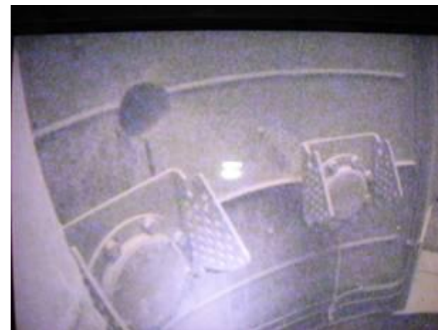
Bridas de la piscina del reactor
