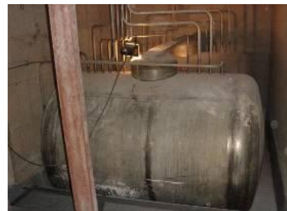
Tanque desmantelado (celda F3)
