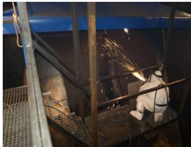
Corte de tanque
