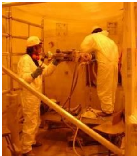
Ejecución de taladros en piscina
