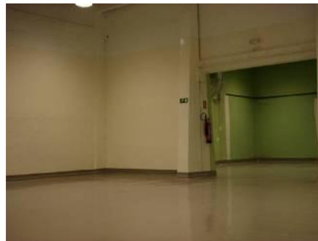
Estado final Edificio 11 Anexo
