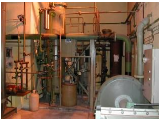
Sala de máquinas (antes)
