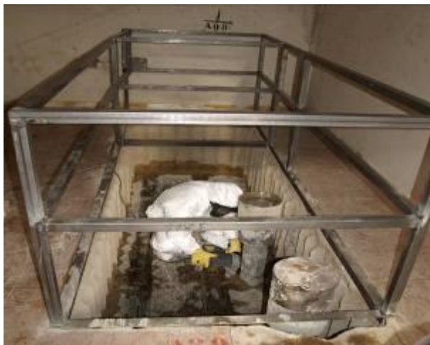
Preparación de accesos a celda subterránea
