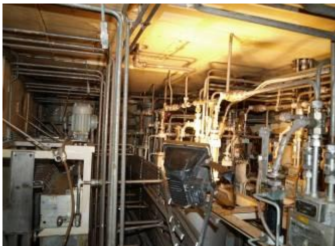
Interior Celda M1
