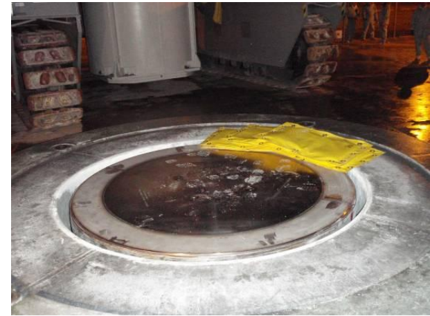
MPC en HI-STORM
