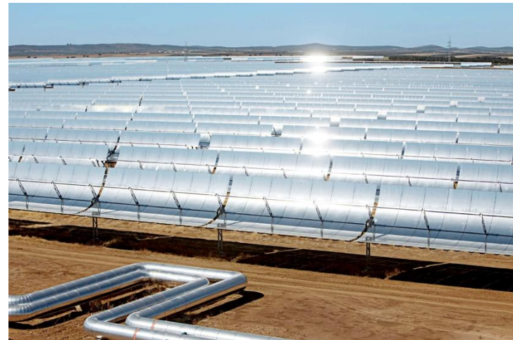
Campo solar de colectores cilindro parabólicos
