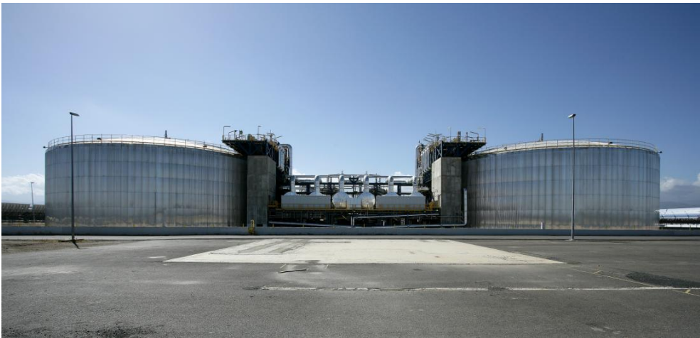
Sistema bitanque de almacenamiento térmico con sales fundidas
