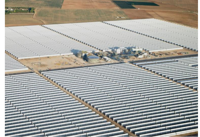
Planta termosolar Manchasol
