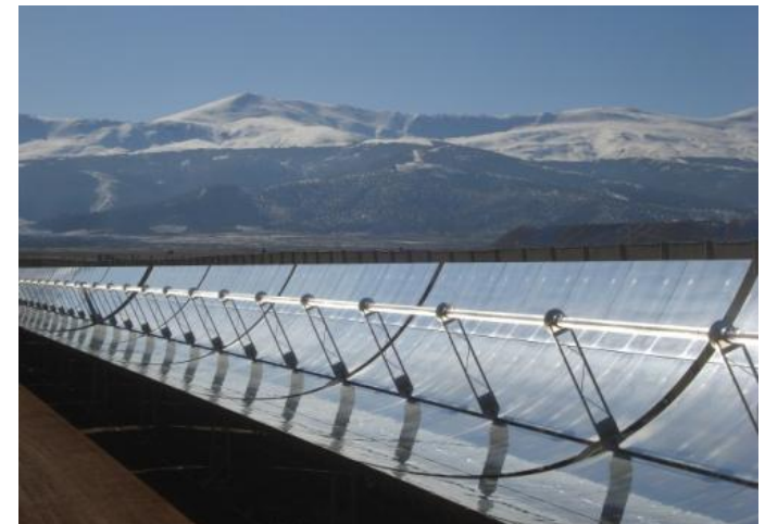
Colectores cilindro parabólicas en Andasol
