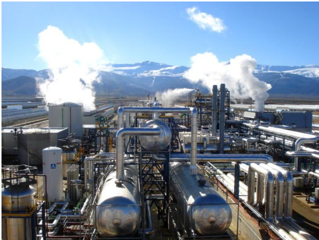
Planta de Andasol en funcionamiento
