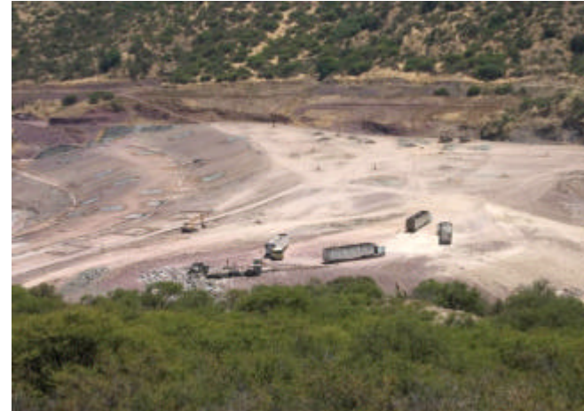
Captura de metano en Relleno Sanitario Santa Marta (Chile)
