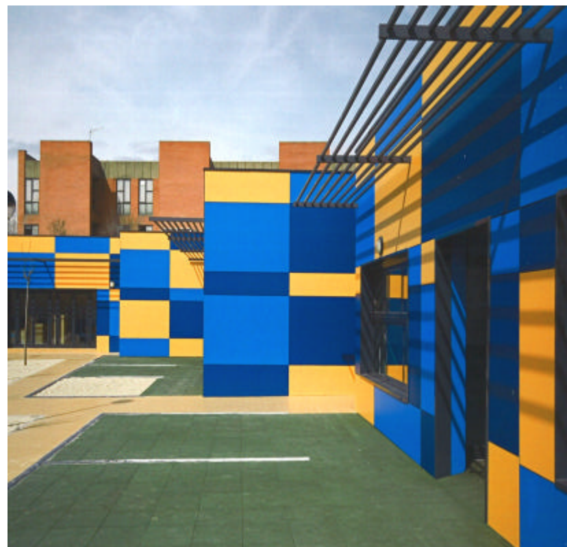
Construcción de escuela municipal infantil, c/José Cadalso
