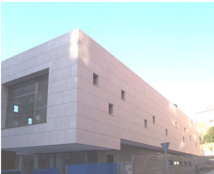
Construcción de un Centro de Día para la Tercera Edad, c/ San Crispín
