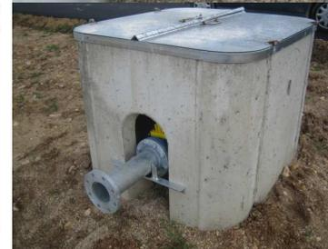
En todas las actuaciones se opta como **criterio de diseño**, proporcionar **en parcela una altura manométrica mínima que oscila entre las 4-5 atmosferas** y una dotación entre **1,2 y 1,6 l/s/Ha**, con un mínimo de 15 l/s.
