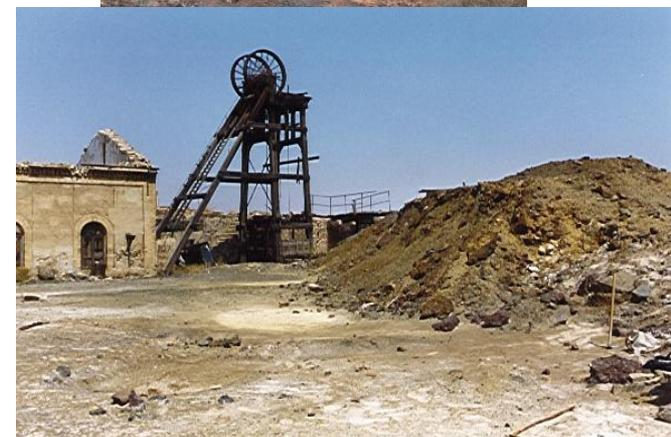
En la actualidad pueden diferenciarse instalaciones características de las construcciones mineras (castilletes, pozos, chimeneas, lavaderos) en diferentes estados de conservación debido al abandono de la actividad junto a escombreras, balsas, restos de escorias de fundición, etc
